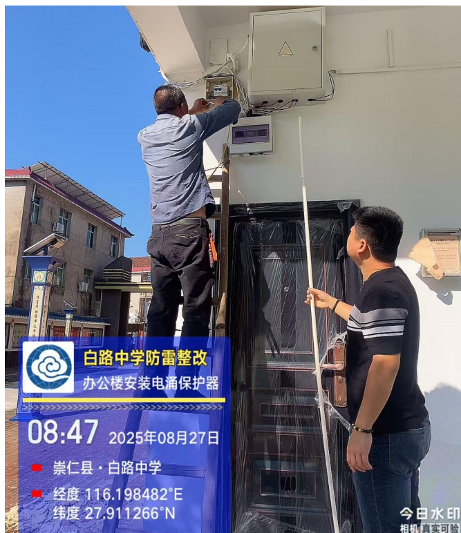
图 6-3 对学校进行防雷设施整改
